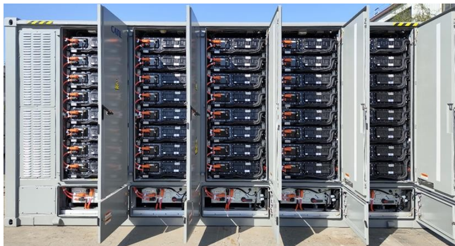
Rysunek 3 Pojemnik do magazynowania energii chłodzony cieczą EnerC --- przegląd zewnętrzny i wewnętrzny
